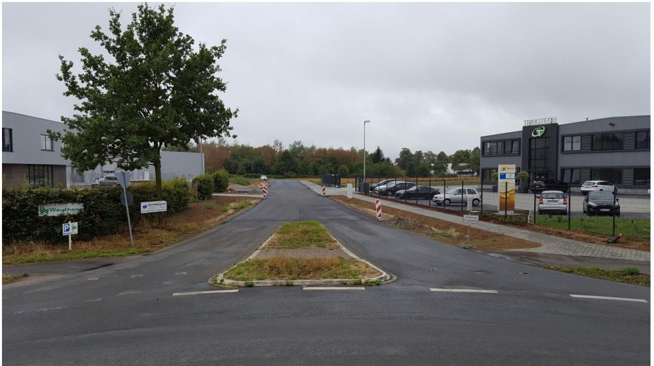
Abbildung 2: Zufahrtsbereich zum Plangebiet mit vorhandener Hallenbebauung; Quelle: Eigene Aufnahme
