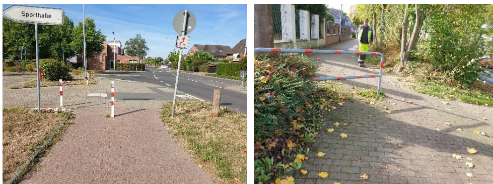
Bild 61: Anwendungsbeispiele für Poller (links) und Umlaufsperrern (rechts) in Schwalmtal (Fotos: IGS mbH)
