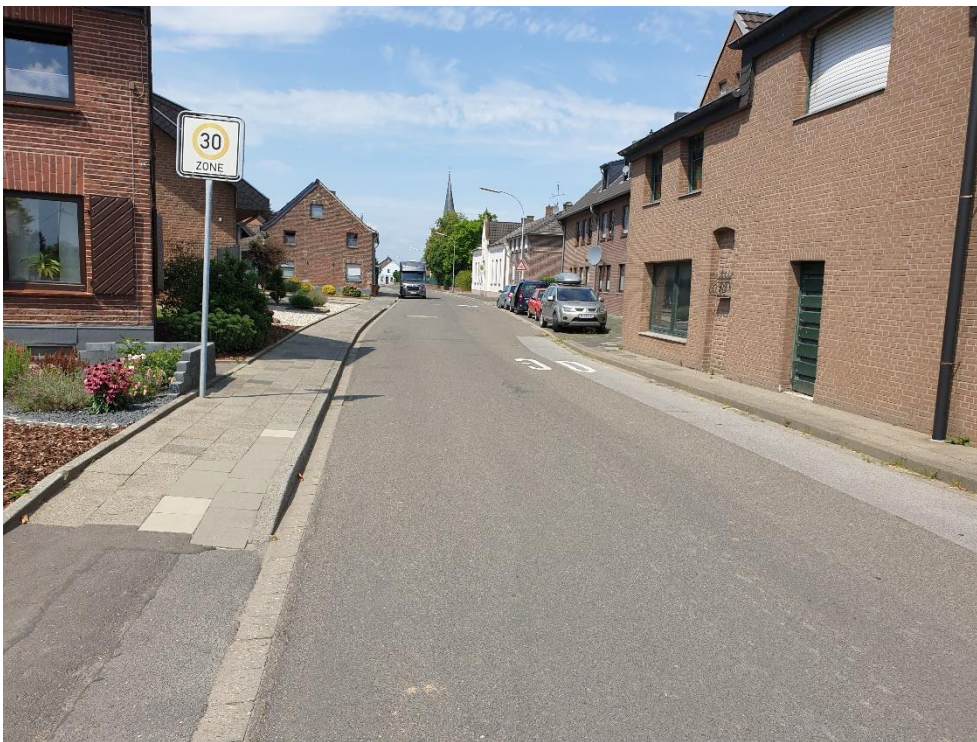
Bild 9: Straßenraum mit geringen Gehwegbreiten in der Nordstraße, Dilkath (Foto: IGS mbH)
