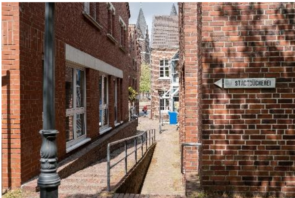
Bild 55: Exemplarische Rampe zur Überwindung von Höhenunterschieden (Foto: IGS mbH)
